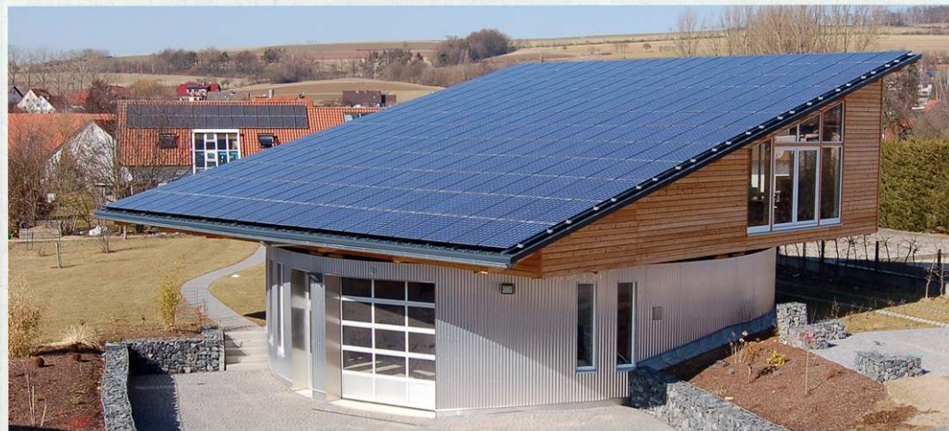
40.000 Watt westwärts: Die Sonne verdreht dem Neotracker in Eichenzell den Kopf. Nachts dreht er ihn wieder zurück.
